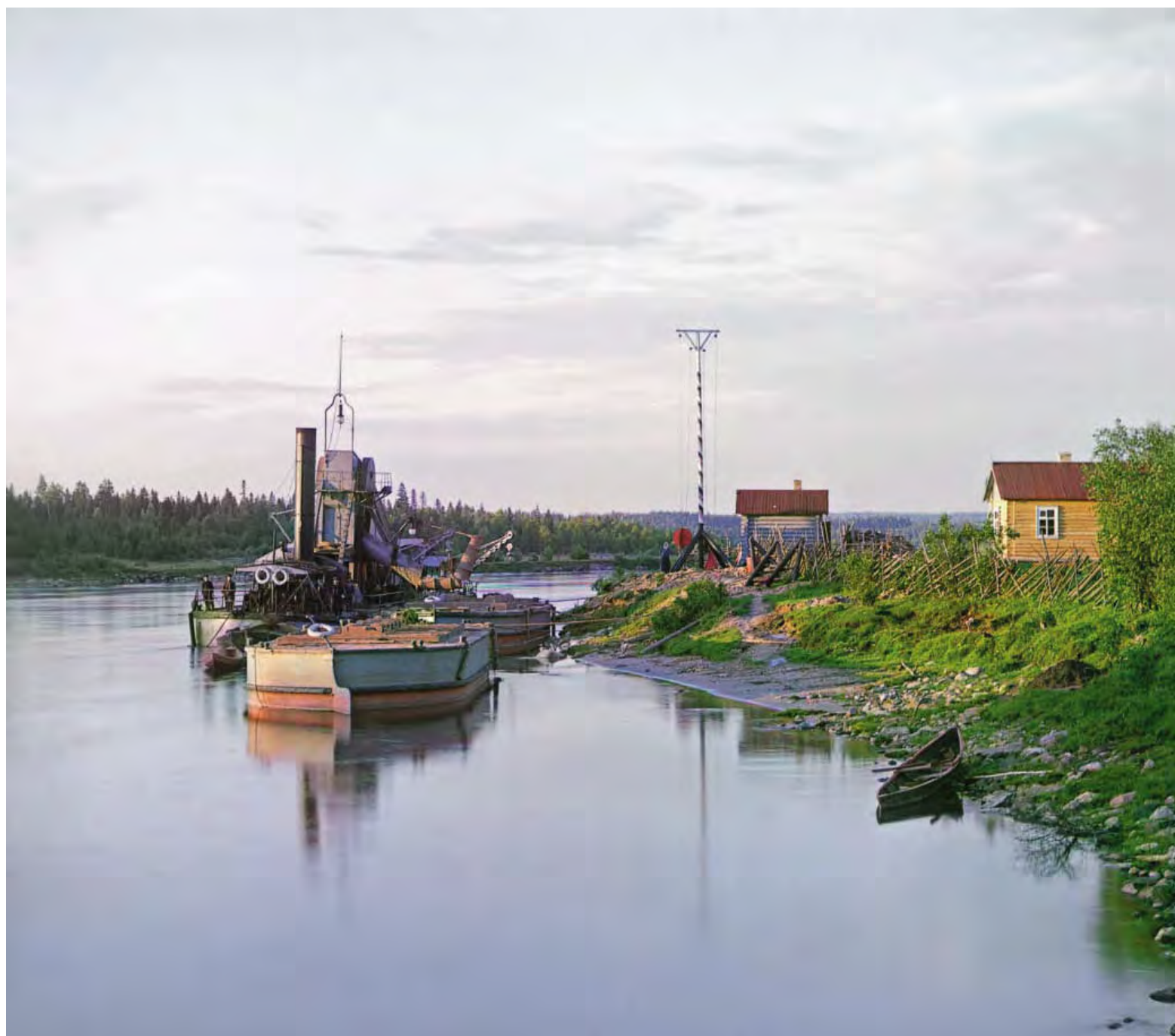
Камнечерпательная машина многочерпакового типа Свирская первая. 1909
