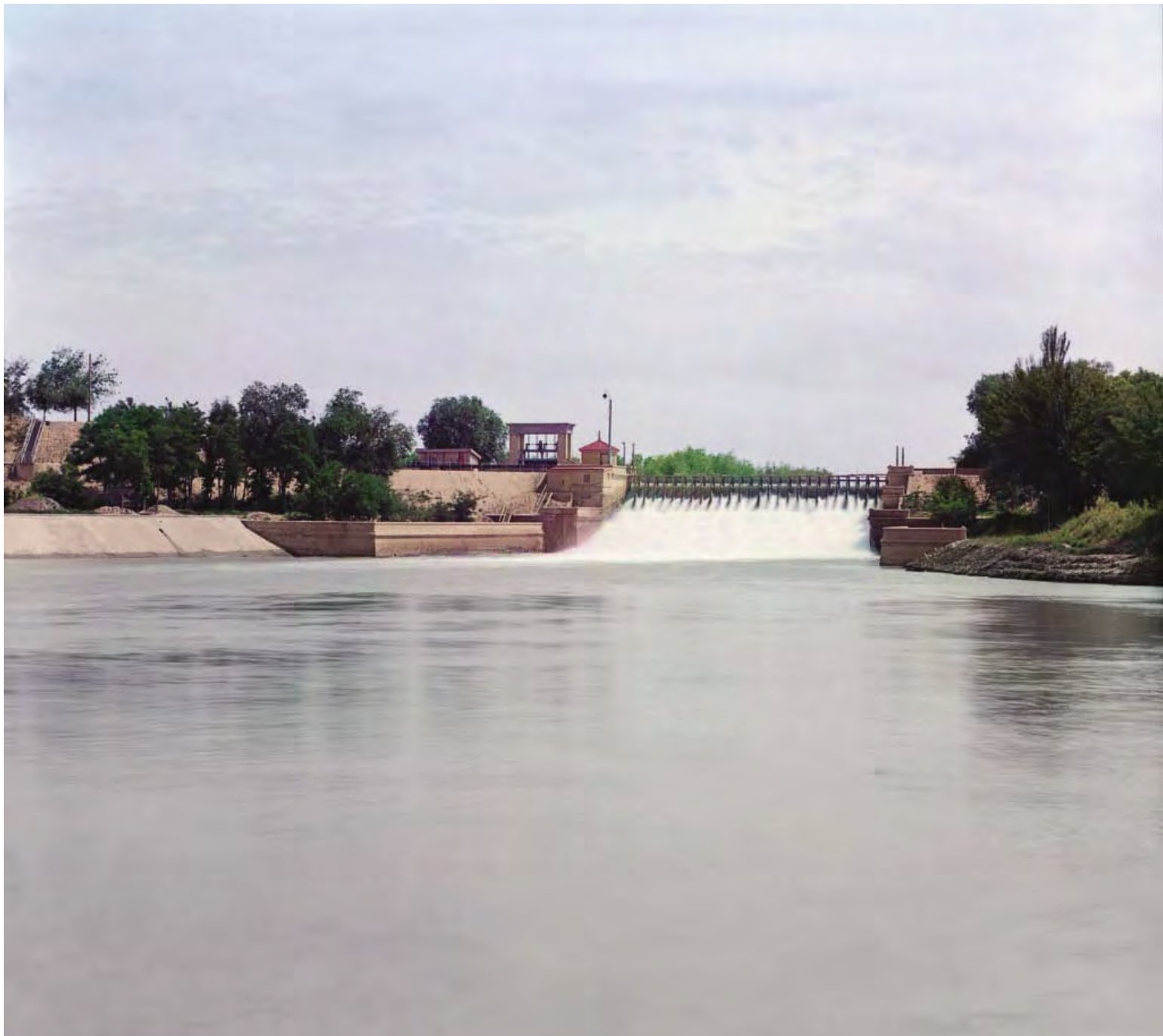
Общий вид электрической станции в Гундукуше (Иолотань). Туркестан. 1911
