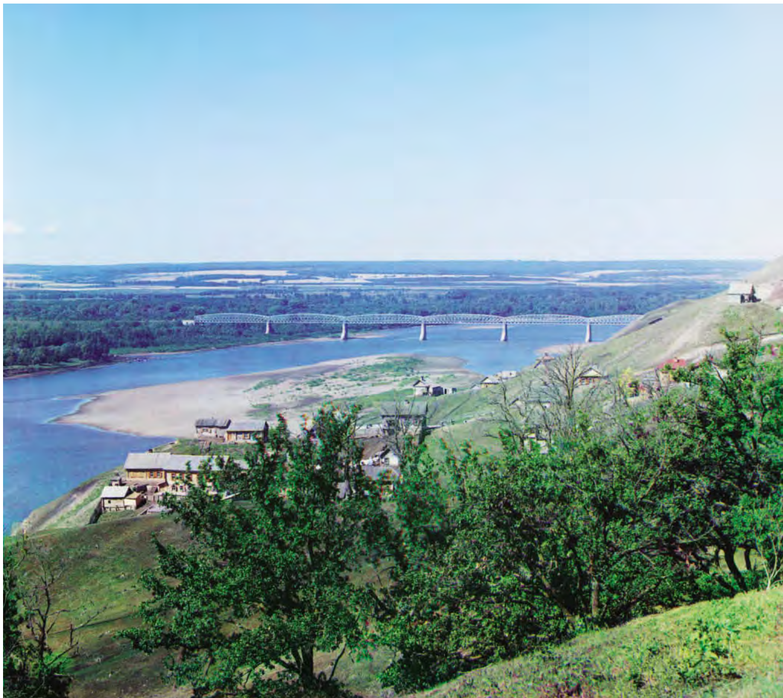
Железнодорожный мост через реку Белую близ Уфы. 1910
