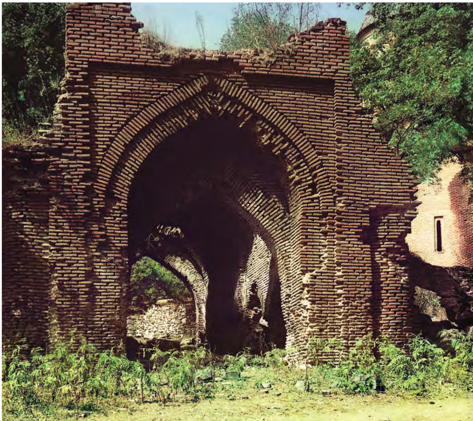
Арка перед входом в Тимотис-Убанский монастырь. 1912 (предположительно)
