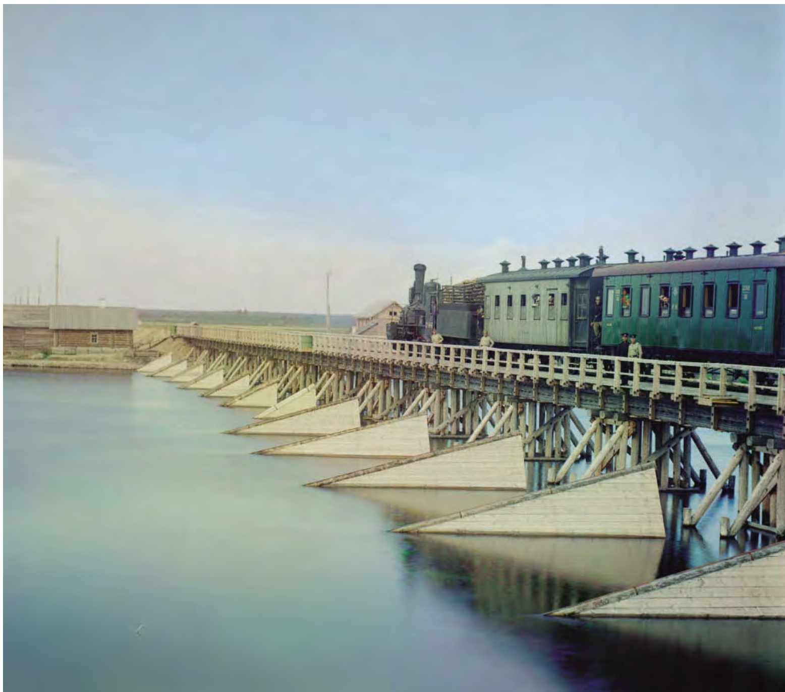
Железнодорожный мост через реку Шую. 1916
